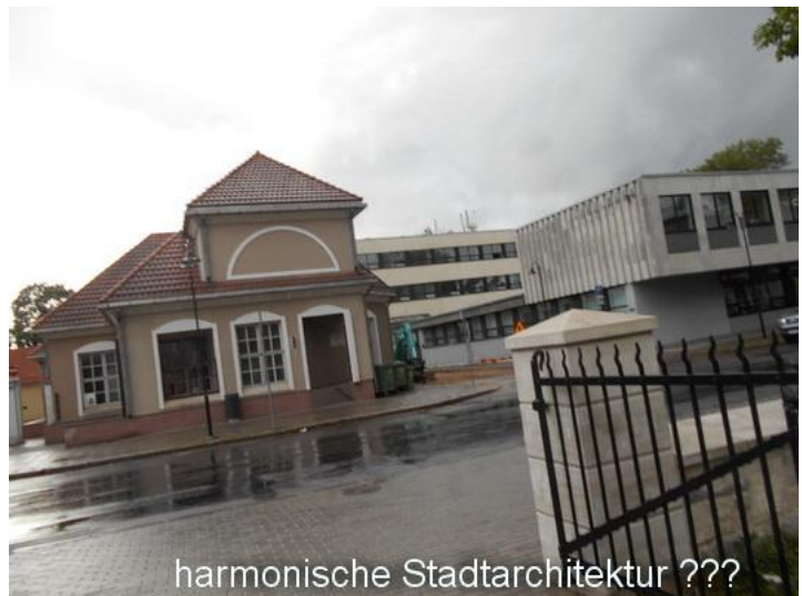
am Marktplatz wird gebaut
